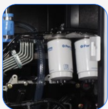
Filtro separador de partículas de combustible
