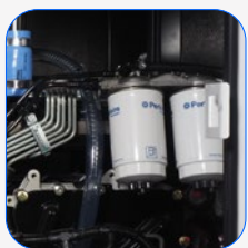
Filtro separador de partículas de combustible
