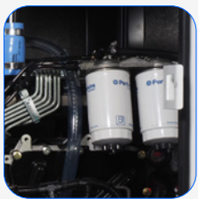
Filtro separador de partículas de combustible
